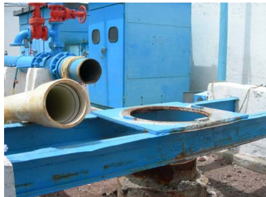
FUENTE: Fotografía tomada por el equipo auditor durante la visita a un pozo en rehabilitación del Ramal Mixquic-Santa Catarina, del Plan de Acción Inmediata.
