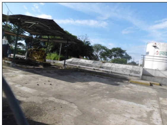
FUENTE: Visita de inspección.
