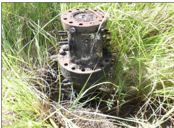
FUENTE: Visita de inspección.
