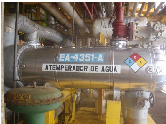
FUENTE: Visita de inspección a la plataforma Akal C-7 de PEP.
