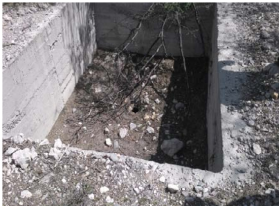
FUENTE: Registro fotográfico de la visita de inspección.
