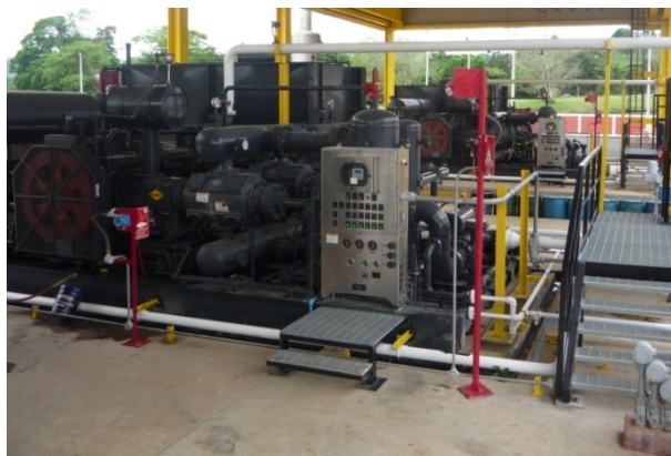
FUENTE: Visita de inspección.
