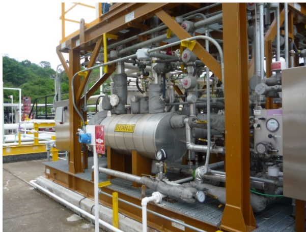
FUENTE: Visita de inspección.
