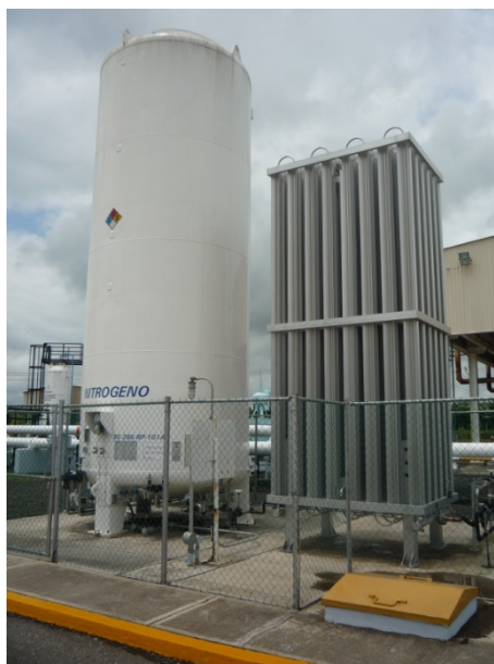
FUENTE: Visita de inspección.
