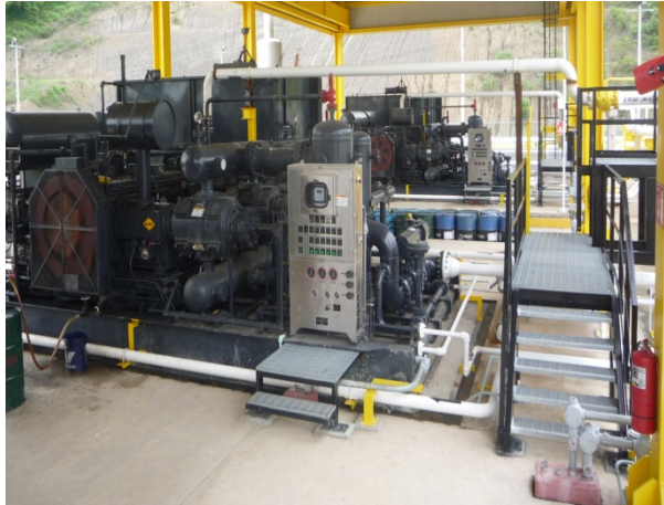
FUENTE: Visita de inspección.
